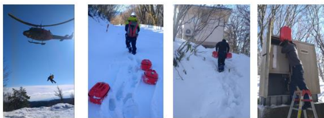
ヘリから降下し、雪が積もる中、1缶20ℓの燃料を局舎まで運び、発電機へ最大200ℓの給油を実施
